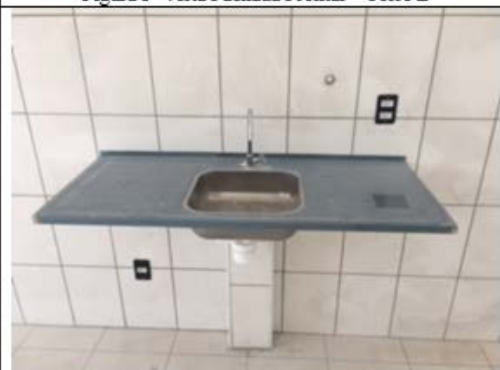
Figura 5- Vista Pia da cozinha
