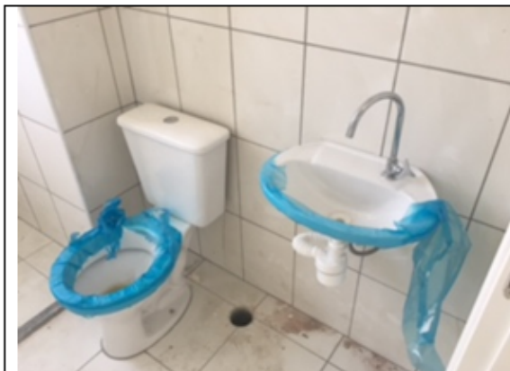
Figura 7– Vista Louça e Metais do Banheiro
