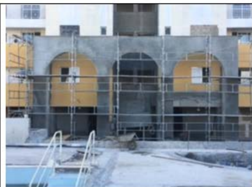
Figura 1- Vista Frontal Pórtico Torre A
