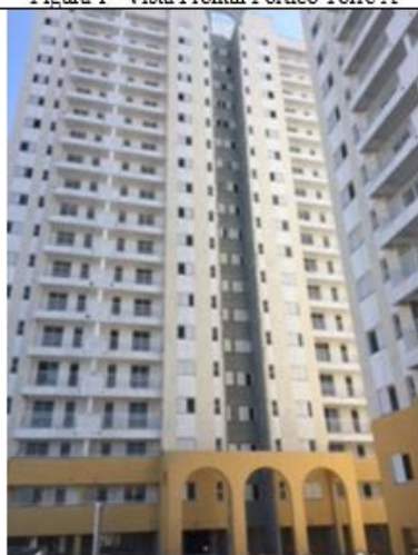
Figura 3- Vista Fachada Frontal - Torre B
