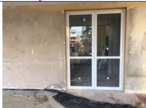
Figura 15 – Vista Porta Entrada Hall Térreo
