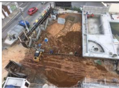
Figura 2- Vista Aterro - Entrada Condomínio
