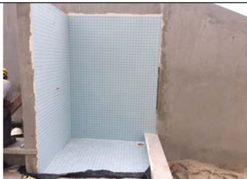
Figura 7– Vista Área da Ducha - Piscinas
