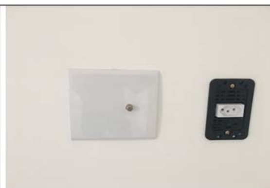
Figura 2–Vista Ponto de Antena e Tomada sem Acabamento
