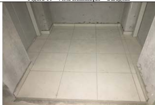
Figura 12– Vista Piso Hall Elevadores - Garagem
