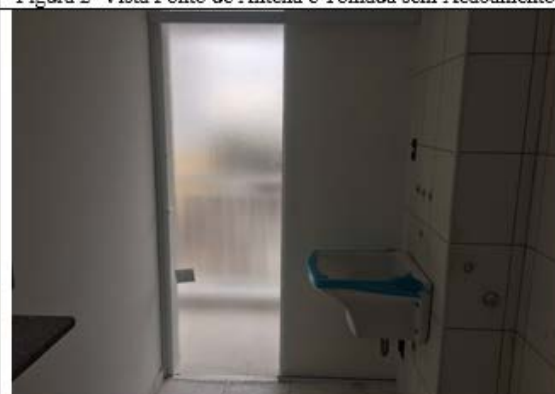
Figura 4– Vista Tanque e Porta Vidro A Serviço - Torre B
