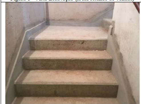
Figura 3- Vista Rodapé Escada - Torre B
