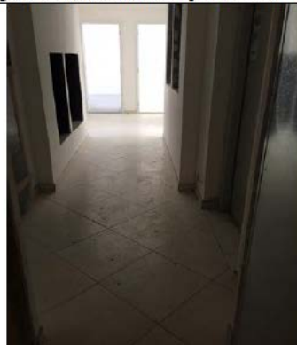
Figura 10– Vista Hall Elevadores - Torre B
