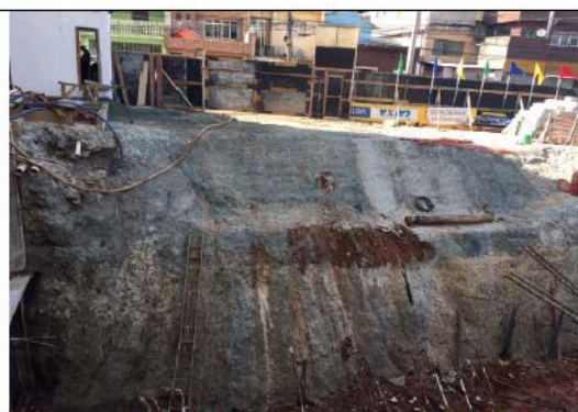
Figura 2- Vista Escavação (local estande de vendas)
