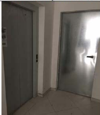
Figura 9– Vista Porta Elevador e P.C.F. – Torre B
