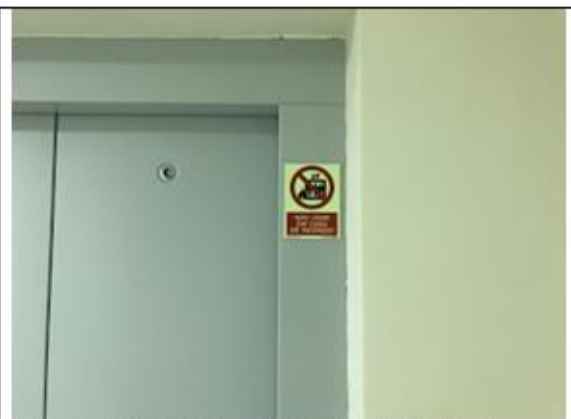
Figura 14– Vista Placa de Incêndio – Porta Elevadores
