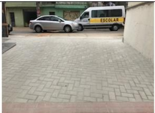
Figura 2- Vista Rampa da Garagem
