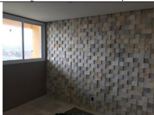
Figura 5- Vista Paredes Sala de Descanso
