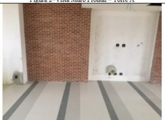
Figura 4– Vista Piso e Parede Fitness
