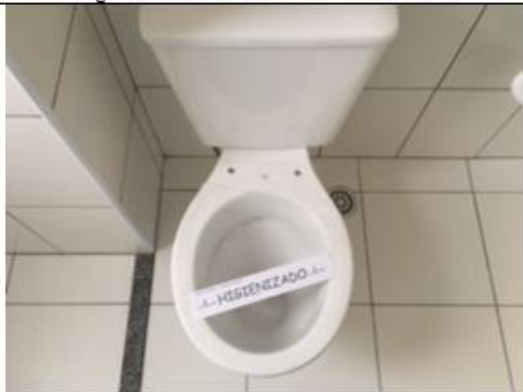
Figura 17 – Vista Banheiro Aptos
