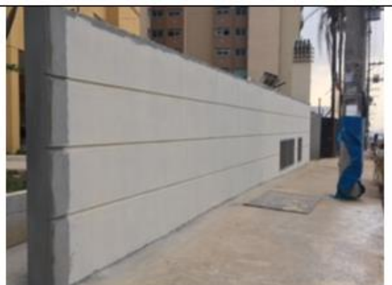
Figura 2–Vista Muro Frontal – Torre A
