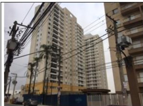
Figura 1– Vista Fachada Fundos Torre A
