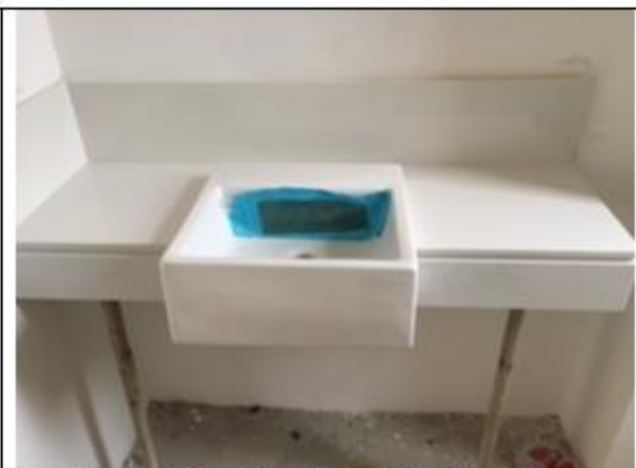
Figura 8- Vista Bancada Banheiro Masc. Térreo
