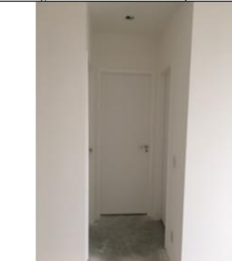
Figura 15 – Vista Hall Entrada Dormitórios
