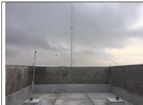
Figura 19– Vista Antena e Para-raio
