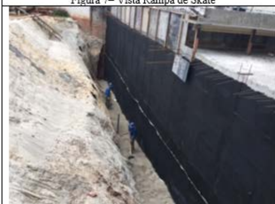
Figura 9– Vista Impermeabilização + Dreno Subsolos
