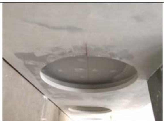
Figura 14– Vista Forro de Gesso - Brinquedoteca
