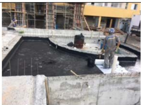
Figura 8– Vista Impermeabilização Piscina Infantil
