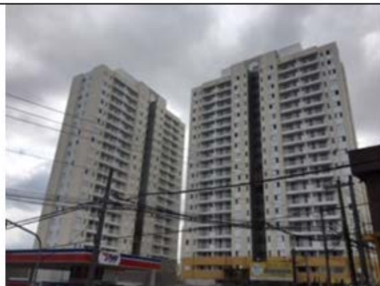
Figura 1– Vista Frontal Fachadas
